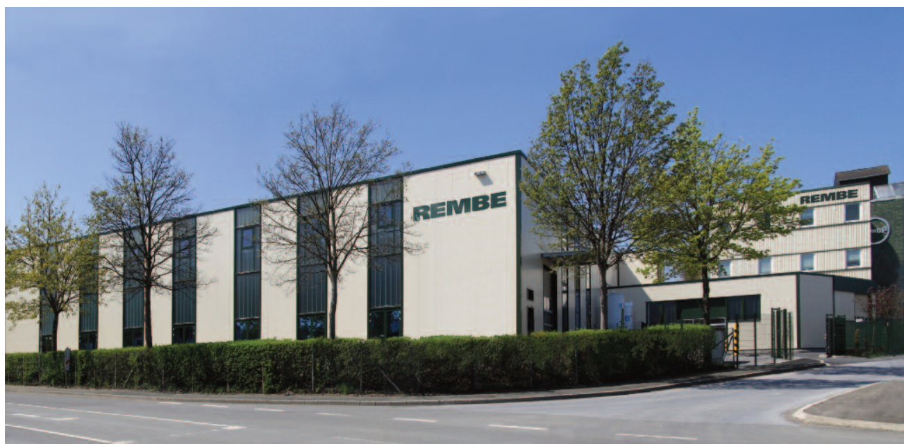
REMBE® офис и производственные площади в г. Brilon, Германия
